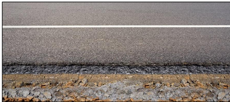
Figura 17. Capas del Pavimento Flexible
