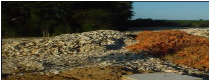
Figura 2. Terraplén construido con residuos de cerámica roja Santa Catarina-Brasil
