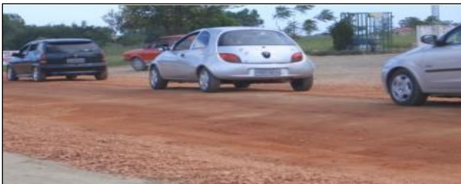
Figura 3. Empleo de residuo de cerámica roja como revestimiento en carretera en Morro de Fumaca-Brasil
