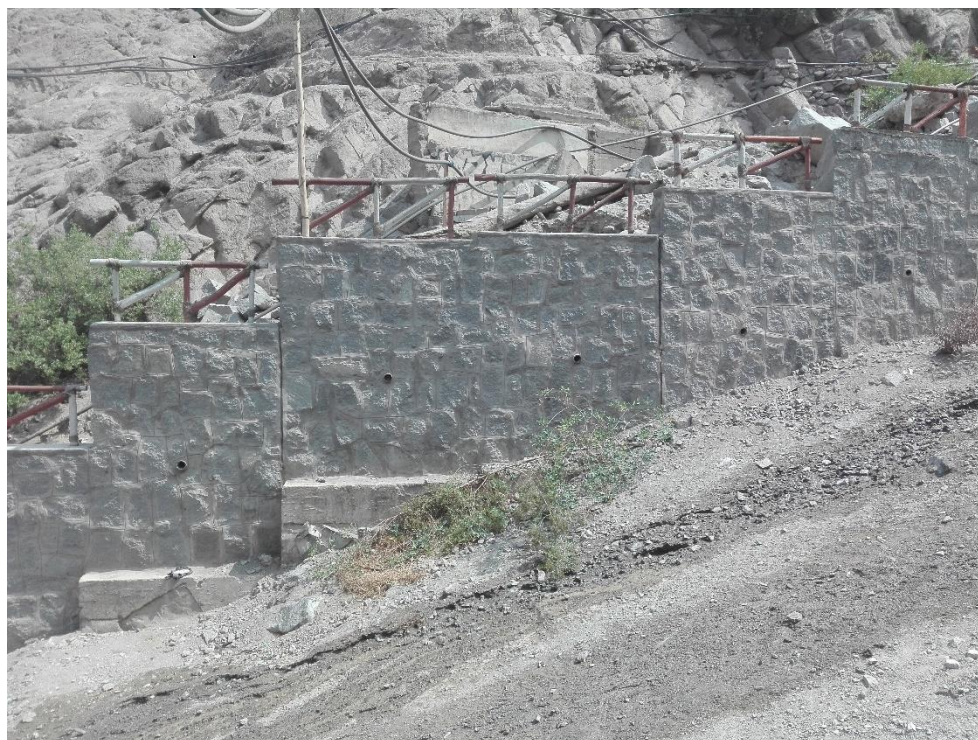
Figura 25. Condiciones actuales del muro de mampostería
