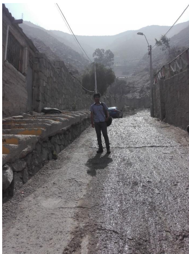
Figura 24. Muro de mampostería Quebrada Carosio
