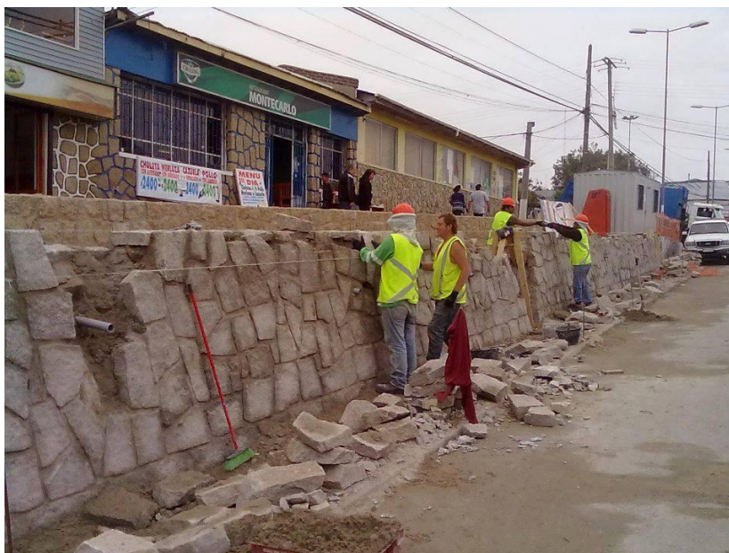
Figura 1. Muros de contención de la zona
