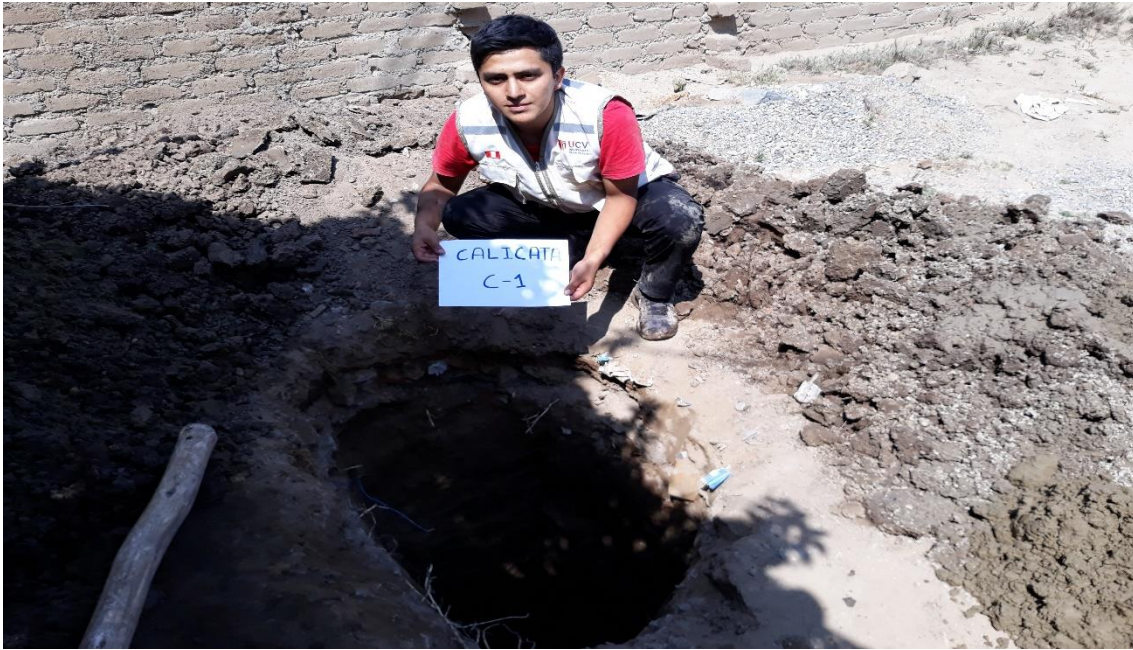
Figura 38: Excavación de calicata para estudio de suelos.
