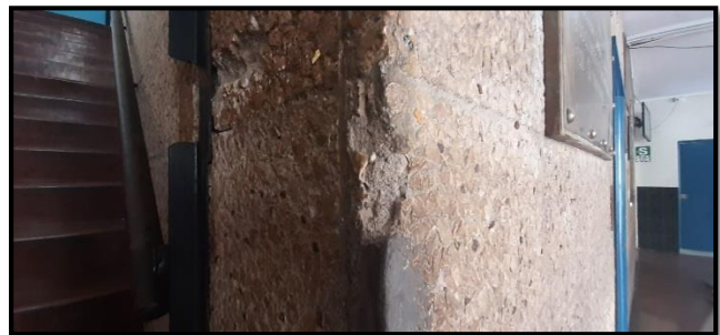
Fotografía N°11.- Vista en fotografía se aprecia los muros recubiertos de baritina.
