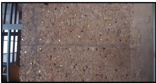
Fotografía N°11.- Vista en fotografía se aprecia los muros recubiertos de baritina.
