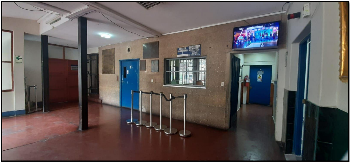
Fotografía N°10.- Vista en fotografía se aprecia el área de rayos X en el hospital arzobispo Loayza, donde se aprecia los muros recubiertos de baritina.
