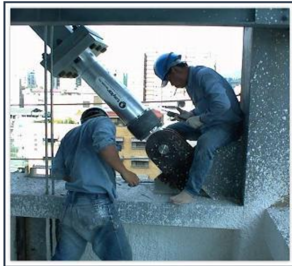
Figura 2. Instalación de disipador de fluido viscoso
