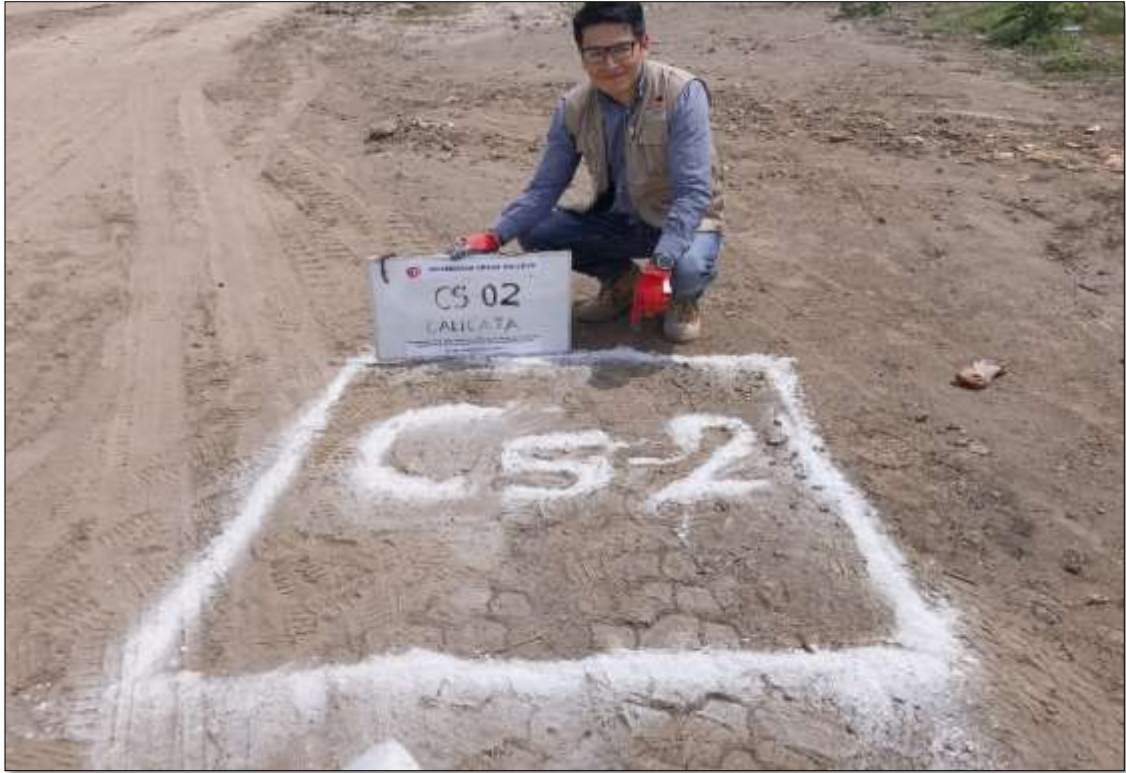
Imagen 9: Ubicación y trazo de la calicata CS-02 en la progresiva 25 + 000.
