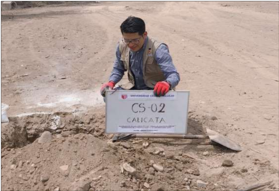
Imagen 10: Ubicación de las calicatas CS-02 en la progresiva 25 + 000 para la toma de muestra de suelo a una profundidad de 1.50m.
