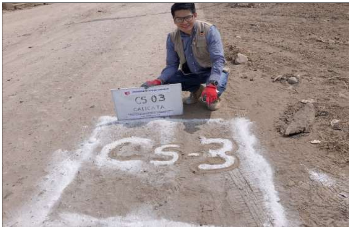
Imagen 13: Ubicación y trazo de la calicata CS-03 en la progresiva 25 + 500.
