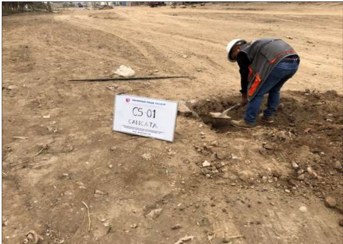
Imagen 6: Excavación de calicata CS-01 progresiva 24 + 500 para recoger muestra.
