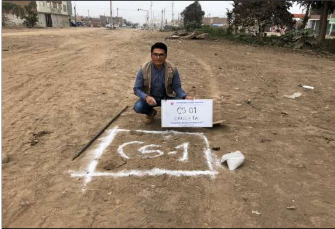
Imagen 5: Ubicación y trazo de la calicata CS-01 progresiva 24 + 500.
