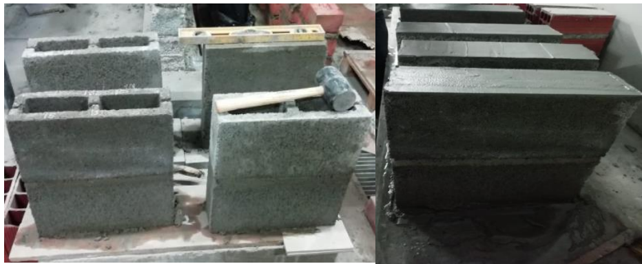
Figura 42: construcción de pila y capeado
