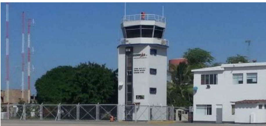
FIGURA N° 7: Torre de control “GUILLERMO CONCHA IBERICO”
