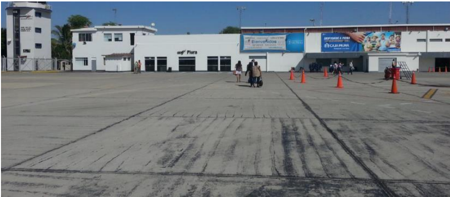
FIGURA N° 5: Plataforma de estacionamiento del Aeropuerto “GUILLERMO CONCHA IBERICO”
