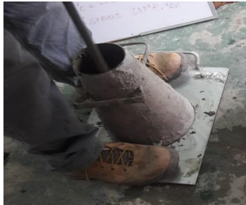
Compactación de cada capa
