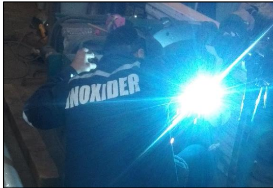
Figura 26. Ejecución de los procesos de soldadura
