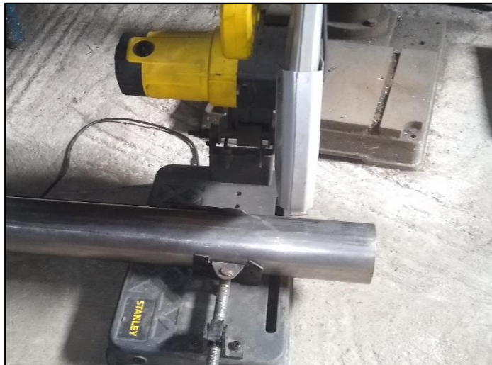
Figura 22. Tronzado de tubería AISI 304
