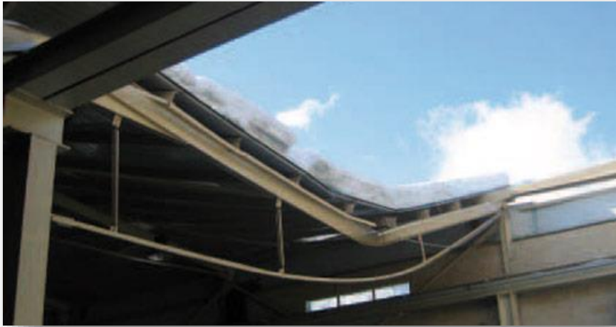
Figura 1. Falla en el pórtico de una nave industrial en Navarra Fuente: Mapfre, 2007
