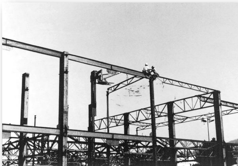
Figura 2. Montaje de vigueta de acero Fuente: McCormac / Scernak, 2012, p. 02
