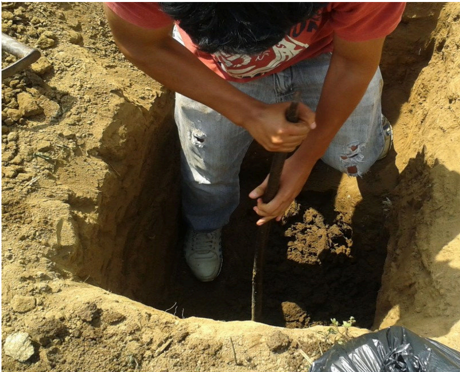
Figura 3: Profundidad de calicata
