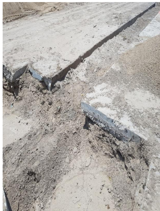
Figura 2 Capa de Concreto
