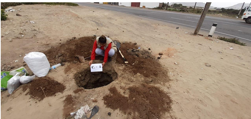
Figura 38. Realización calicata C-1
