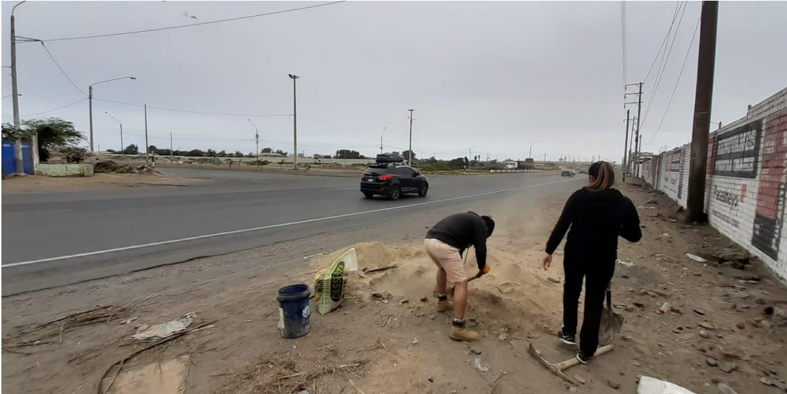
Figura 40. Excavación de la segunda calicata C-2
