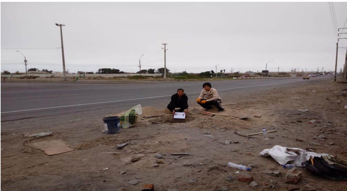
Figura 39. Realización de la calicata C-2
