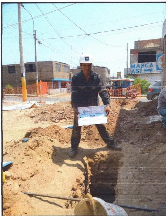
Foto N° 2: Se muestra la exploración de la C-2, la cual presenta, un 16.66% de relleno no controlado, un 13.33% de arena limosa, un 20.00% de arena arcillosa y 50.01% de grava limosa con arena.
