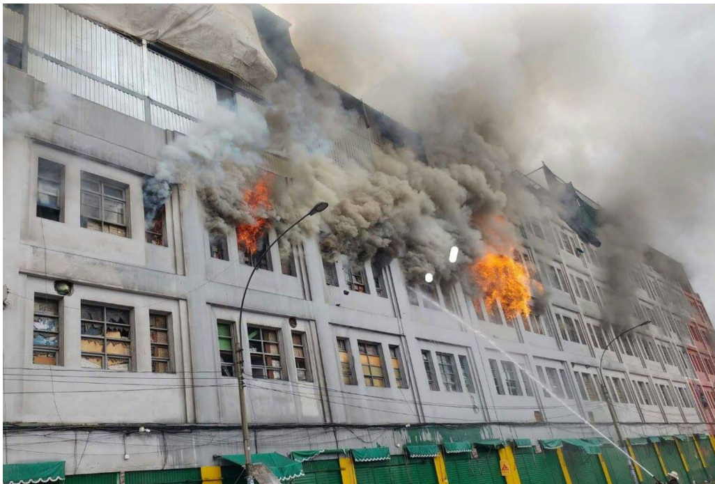
Figura 3. 1 Centro comercial Las Malvinas
