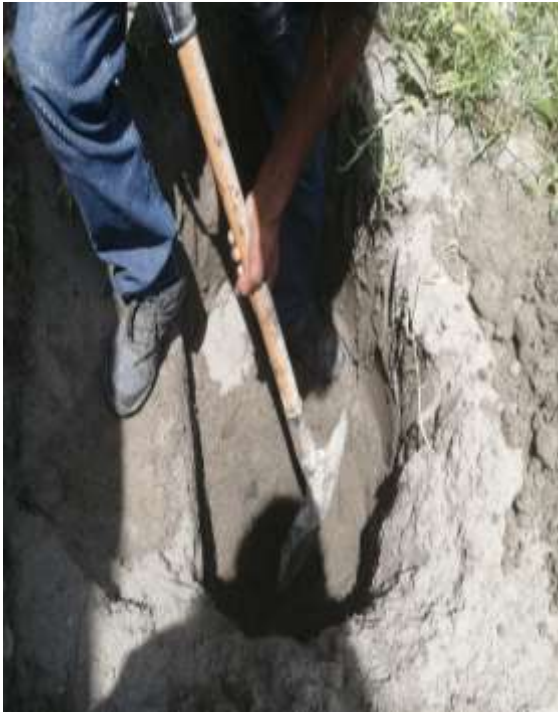
Figura: Excavación manual de la calicata C-1
