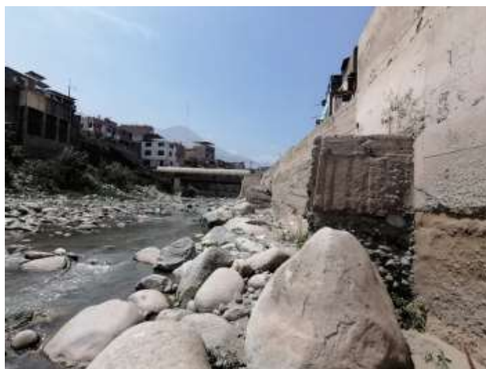
Figura: Vista del muro de defensa ribereña en la zona del Pedregal
