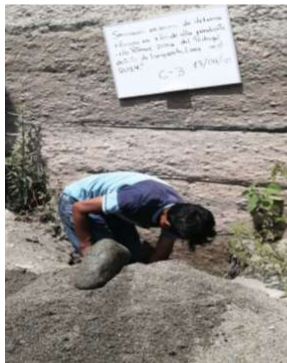
Figura: Excavación manual de la calicata C-3
