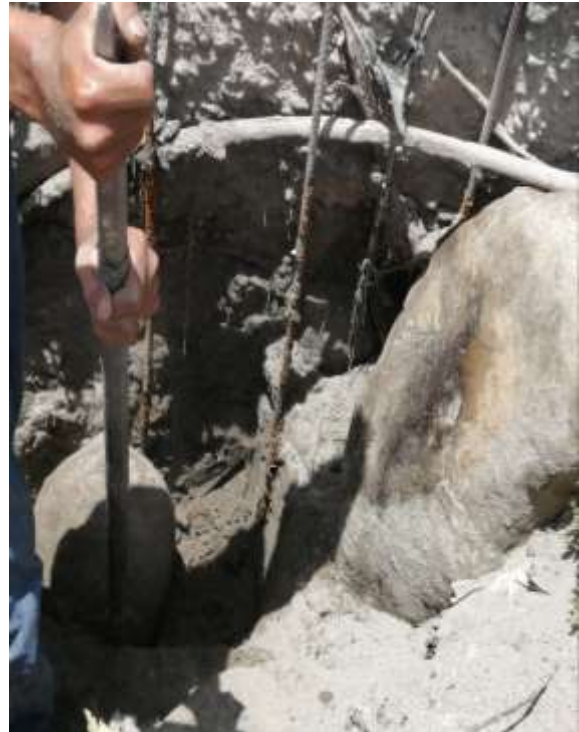
Figura: Excavación manual de la calicata C-2
