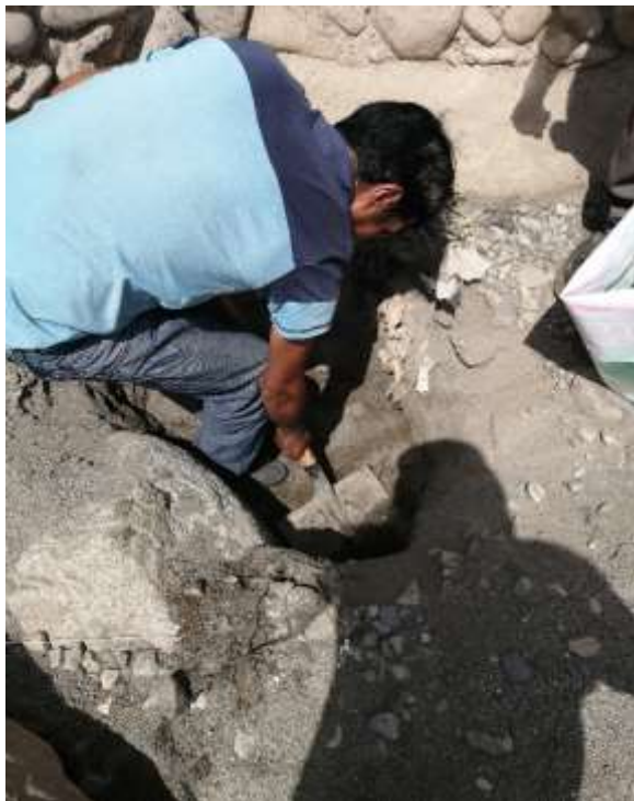
Figura: Excavación manual de la calicata C-3
