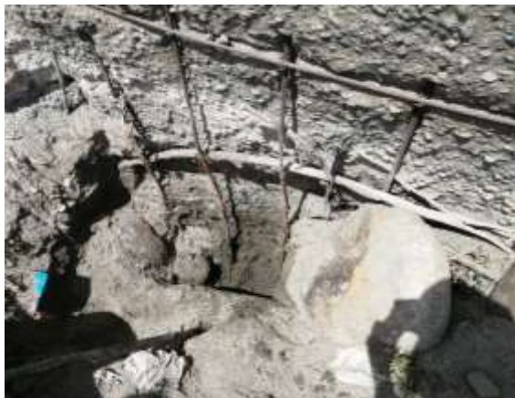
Figura: Estado actual de la cimentación
