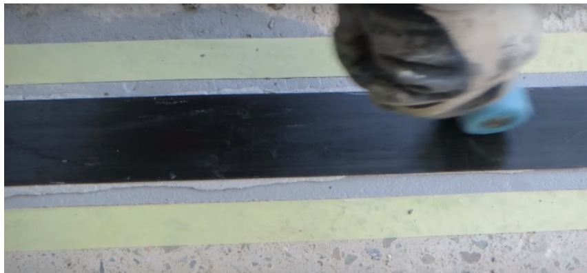
Figura 1.61 Corte de la fibra de carbono Carbodur vigas
