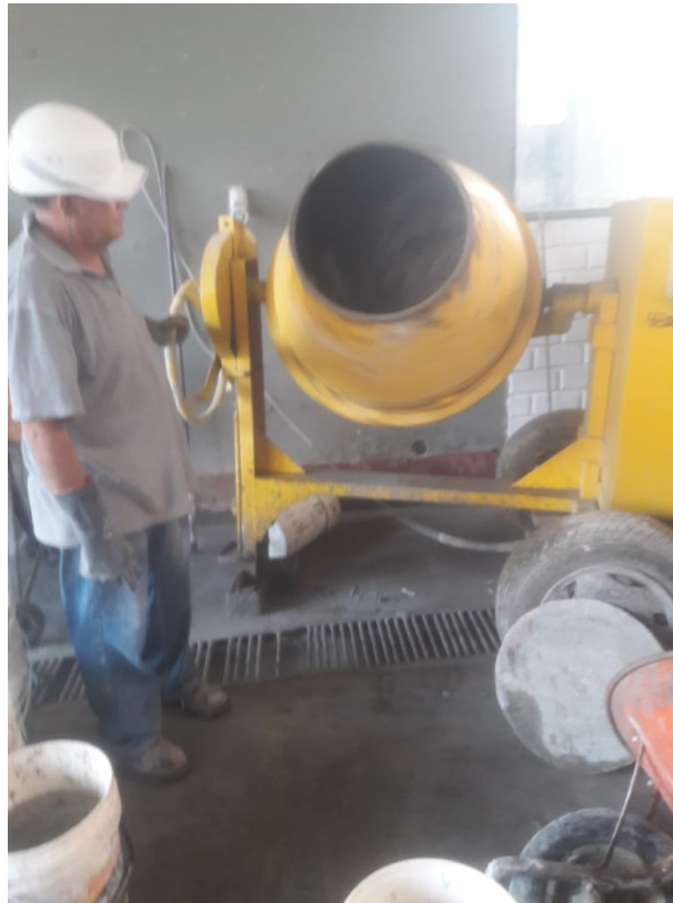
Figura 1.22 Mezclado de los agregados
