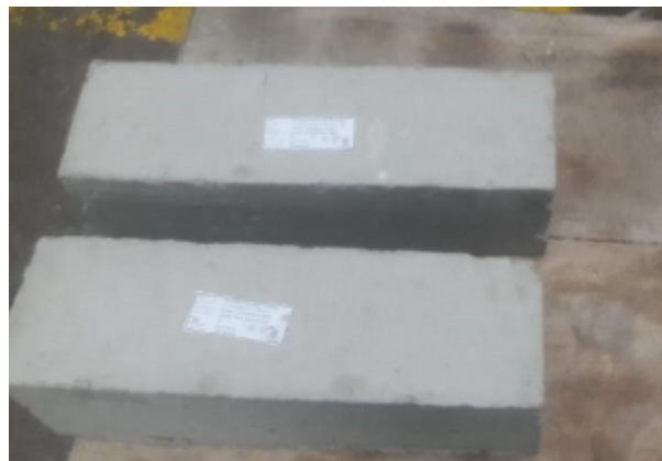
Figura 1.59 Desencofrado de vigas
