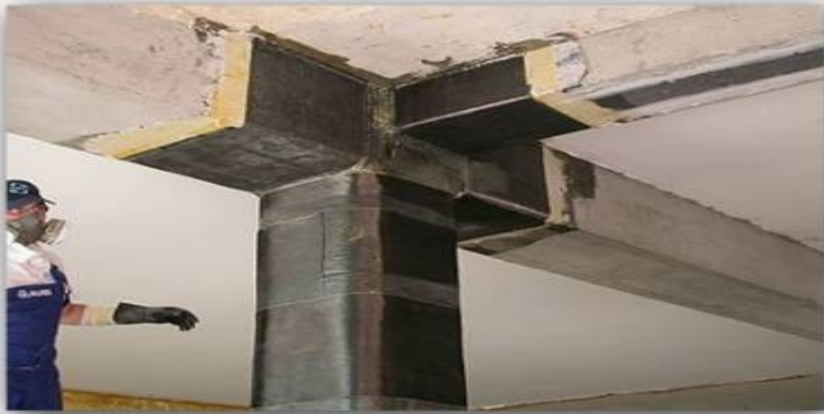
Figura 1.9. Colocación de fibra de carbono en toda su longitud
