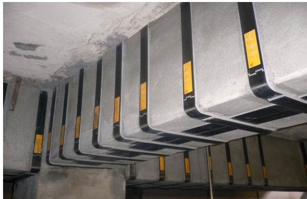
Figura 1.8. Refuerzo estructural por corte
