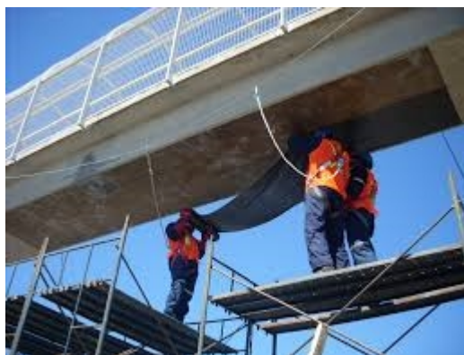
Figura 1.7. Refuerzo estructural por flexión
