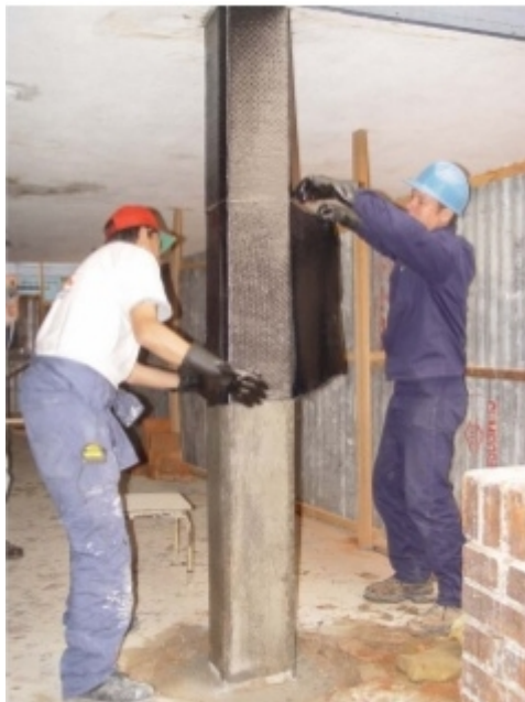
Figura 1.6. Colocación de la fibra de carbono
