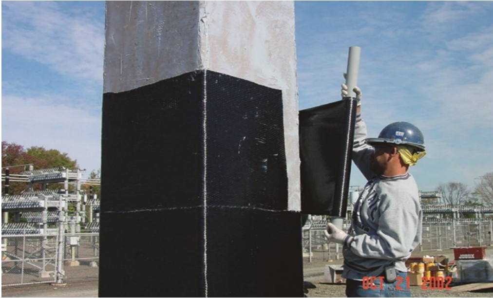
Figura 1.2. Fibras de carbono en columnas
