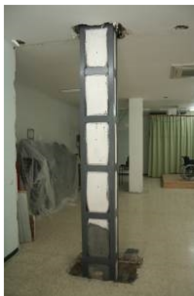
Figura 1.11. Refuerzo estructural por compresión
