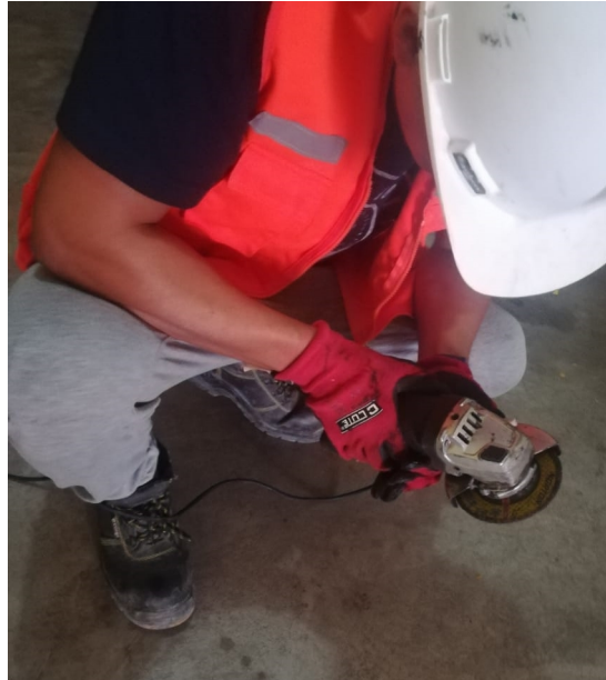
Figura 1.60 Escarificando con amoladora
