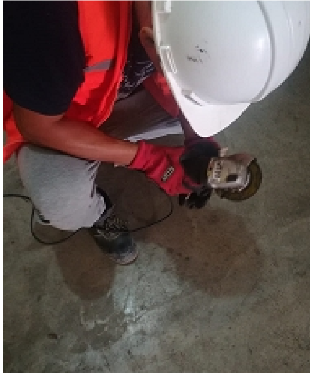
Figura 1.46 Escarificando con amoladora
