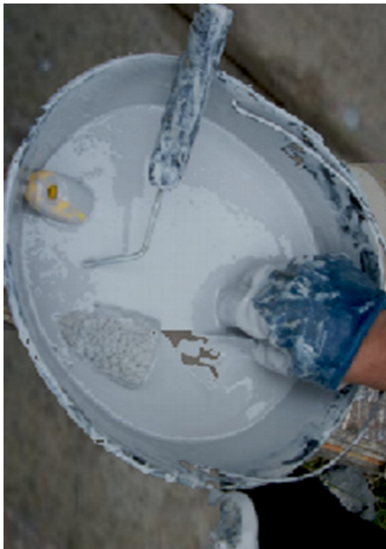
Figura 1.49 Mezcla de los componentes Sikadur - 301
