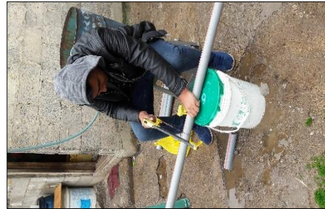
e) Instalacion de tuberías de PVC
