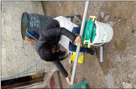
e) Instalacion de tuberías de PVC
