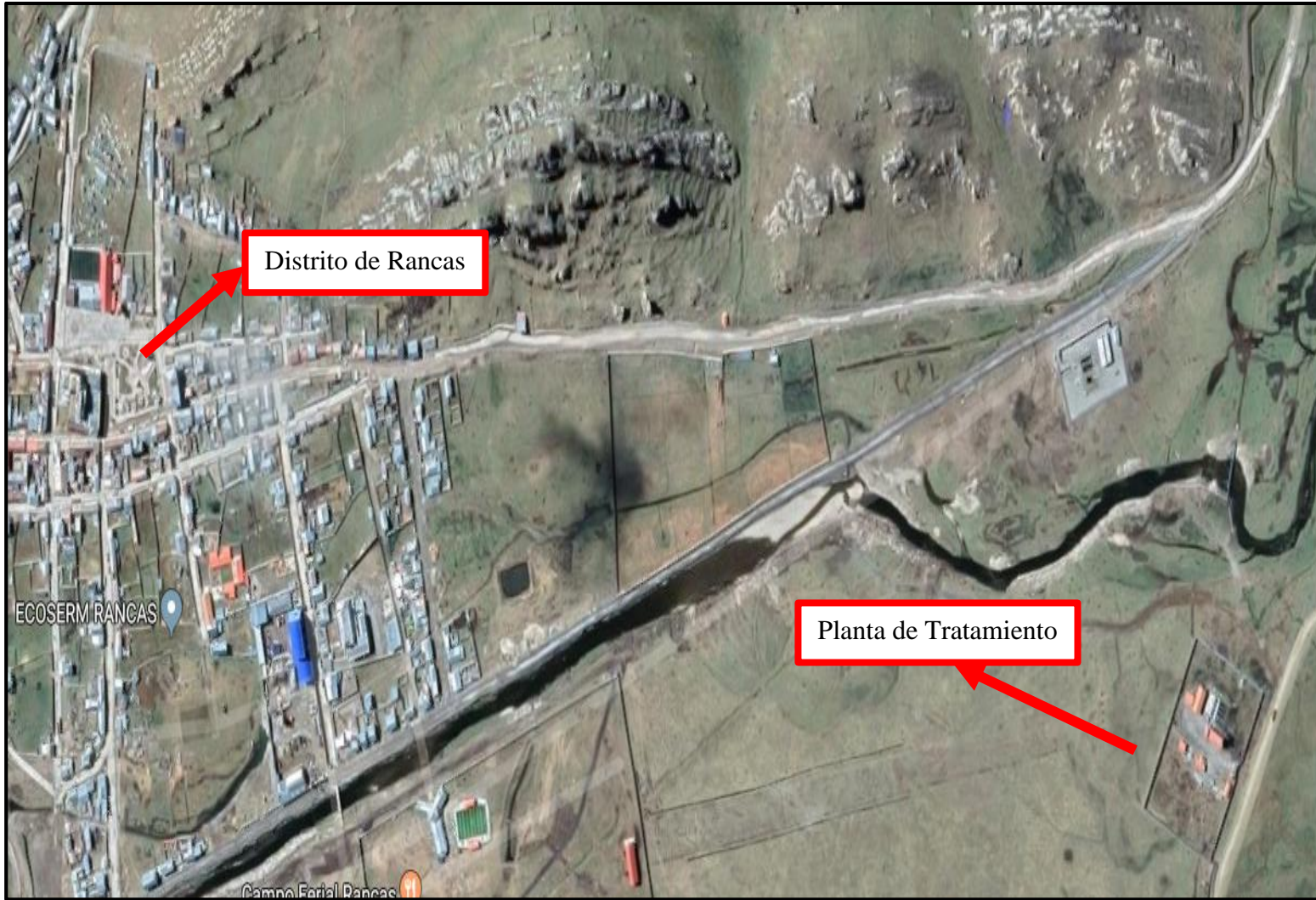
Figura 12. Planta de tratamiento en el Distrito de Rancas.
