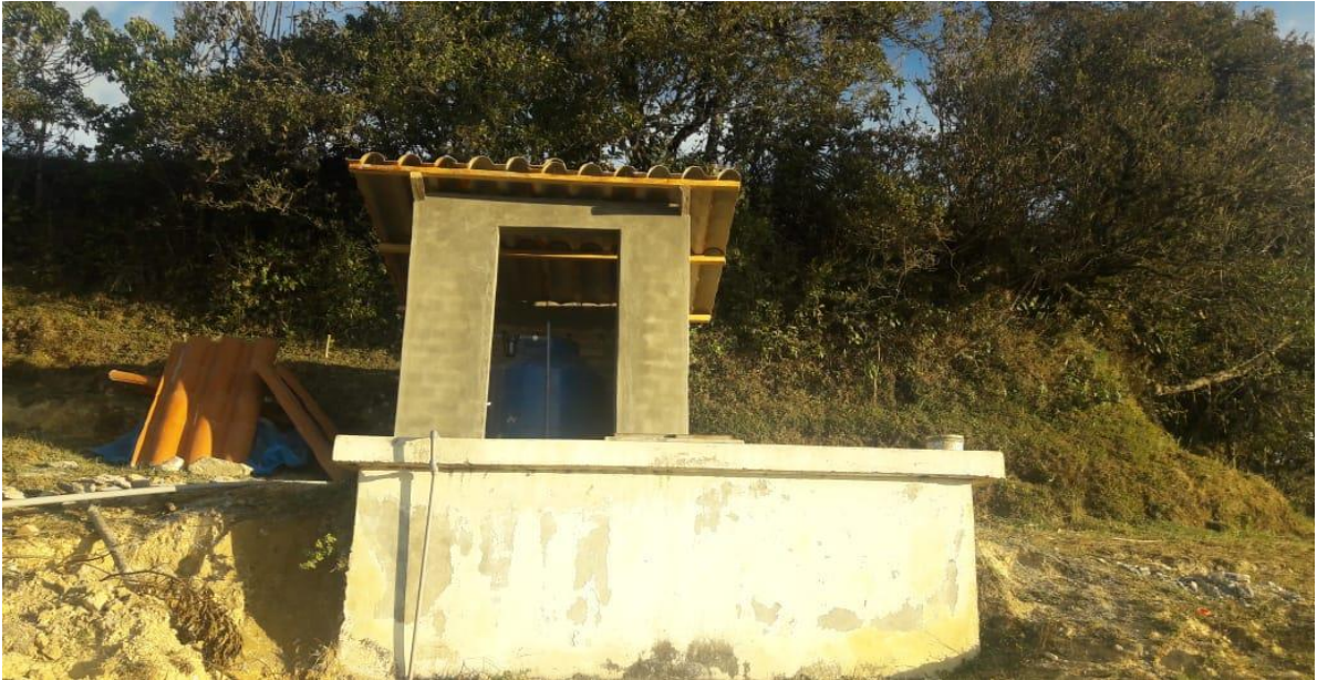
Foto 03: Acabados de la caseta de cloración. Coyunde Grande 11 de octubre del 2019.
