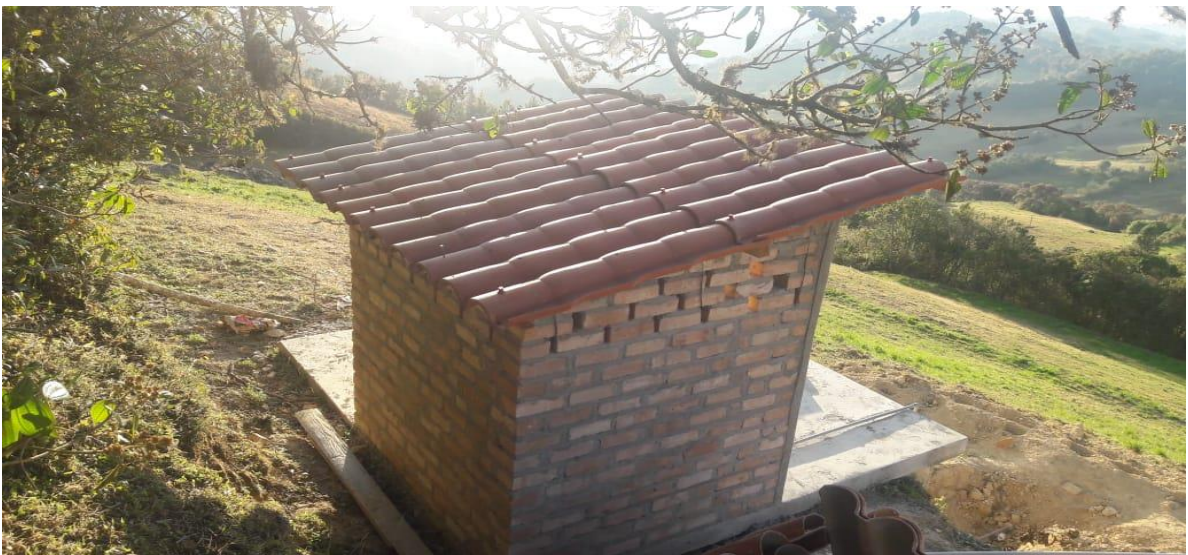
Foto 02: Finalización de la caseta de cloración. Coyunde Grande 07 de octubre del 2019.
