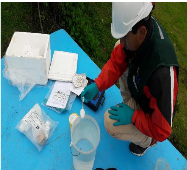
Foto 08: Recojo disolución del hipoclorito de calcio para el tratamiento de agua del manantial Cashesirque reservorio N° 1. Coyunde Grande 07 de noviembre del 2019.
