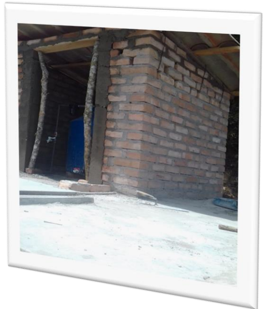
Foto 01: Participando de la construcción de la caseta para el tanque de cloración. Coyunde Grande 20 de setiembre del 2019.
