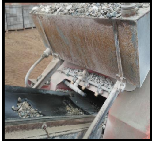
Figura 12: Trituración de escombros
