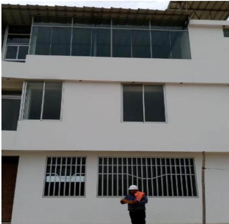
Figura 7. Vivienda de tres niveles con sistema estructural de albañilería Fuente: Elaboración propia.
