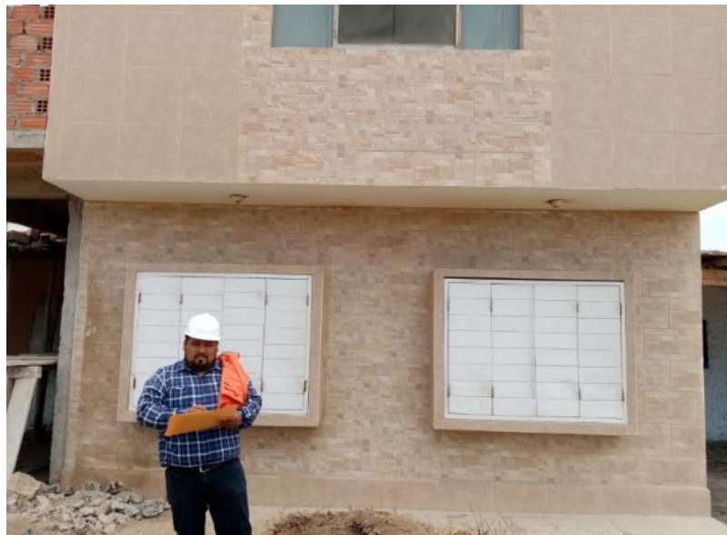
Figura 5. Vivienda de dos niveles con sistema estructural de albañilería Fuente: Elaboración propia.
