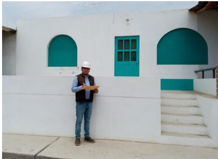
Figura 4. Vivienda de un nivel de albañilería confinada Fuente: Elaboración propia.
