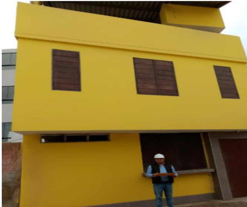
Figura 8. Vivienda de tres niveles con sistema estructural de albañilería Fuente: Elaboración propia.
