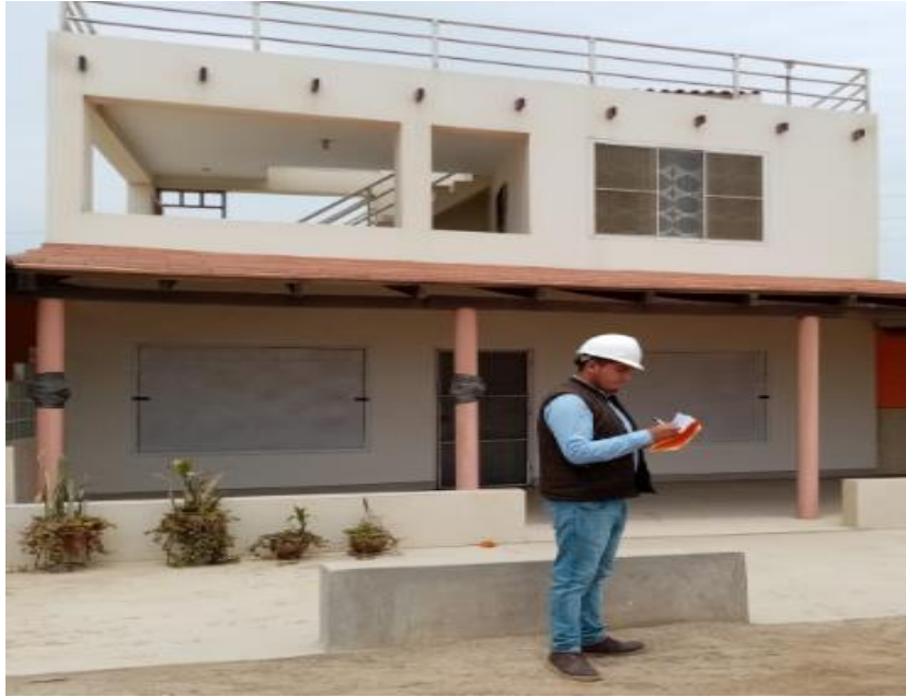
Figura 6. Vivienda de dos niveles con sistema estructural de albañilería Fuente: Elaboración propia.
