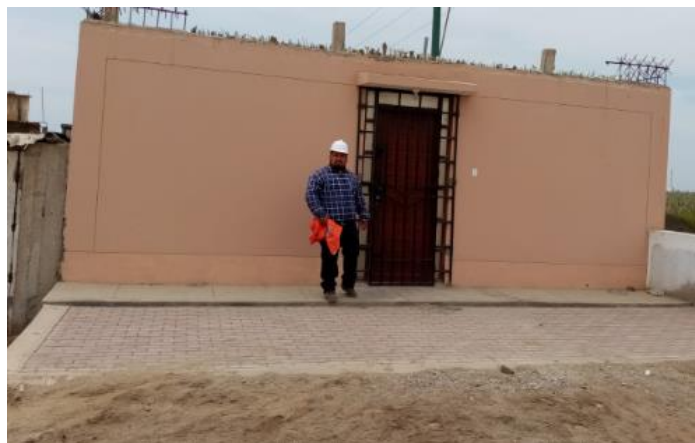
Figura 3. Vivienda de 1 nivel de albañilería confinada.
