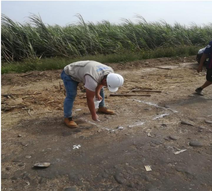
Figura 51: Marcación de la calicata que se va a excavar
