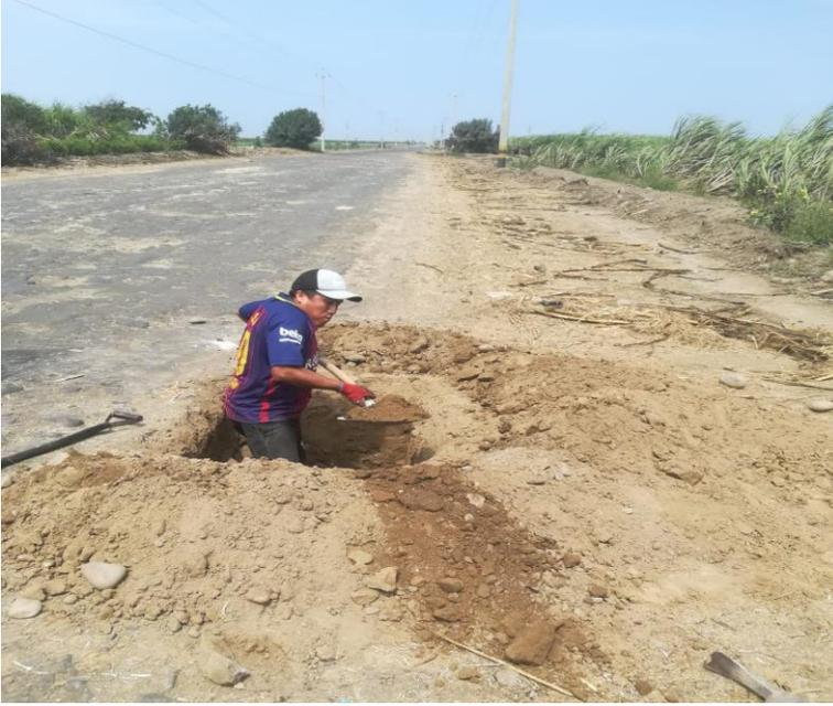
Figura 53: Excavación de la calicata.
