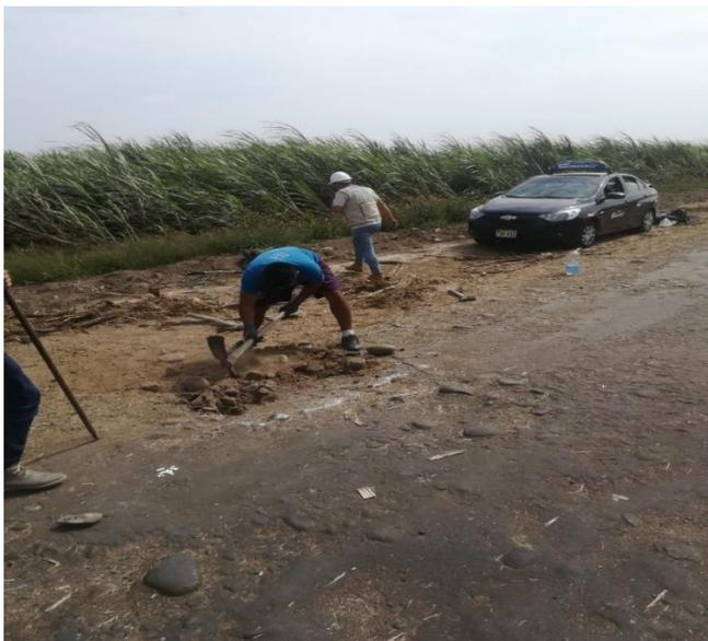
Figura 52: Excavación de la calicata.
