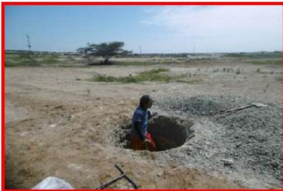
Foto 1. Ubicación de Calicata C-1.
