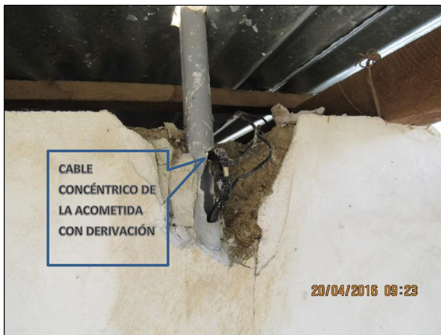
Figura 18. Hurto de energía en acometida.
