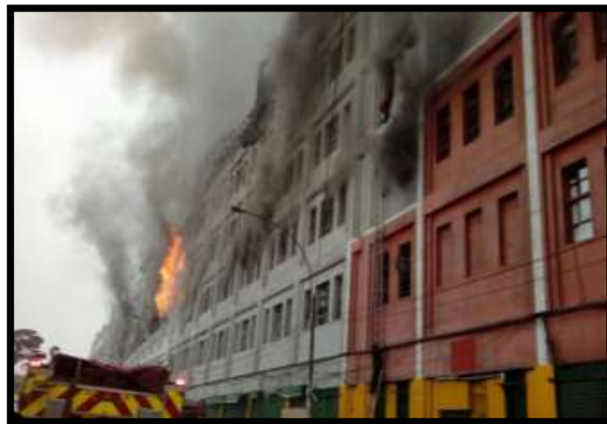
Figura 1.1. Incendio en la Galería Nicolini, 2017.
