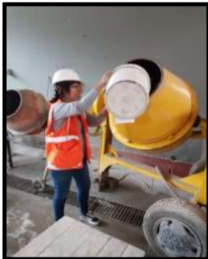
Figura 3.9 Colocación del Material a la Mezcladora
