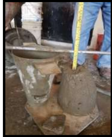
Figura 3.12 Verificación del slump
