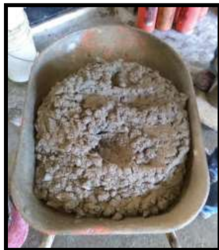
Figura 3.10 Mezcla del Concreto
