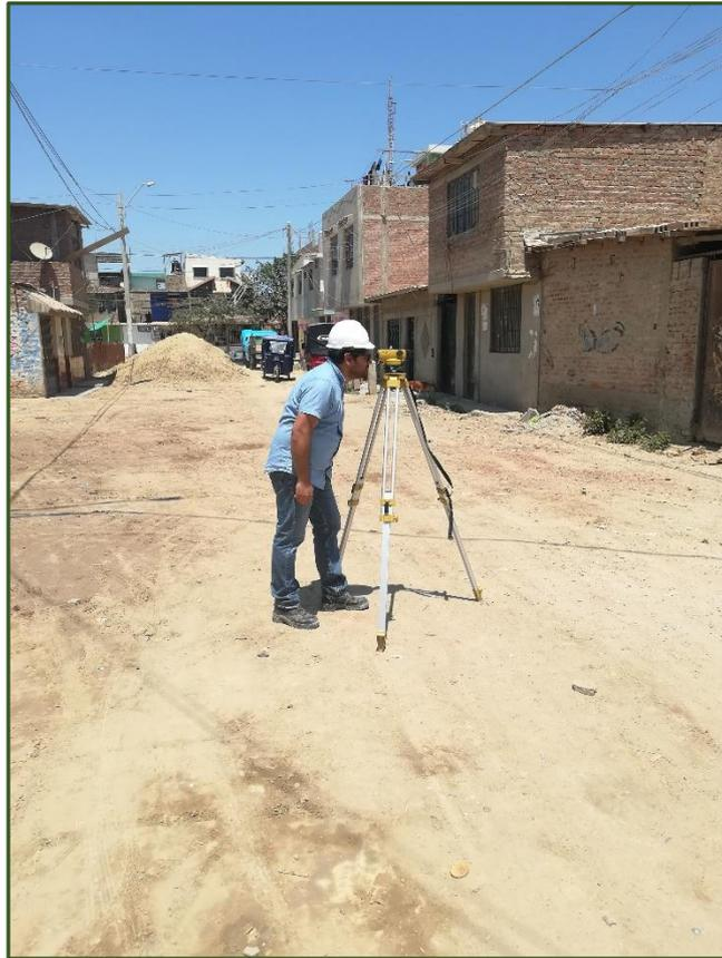
Figura N° 3.5. Realizando levantamiento topográfico
