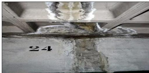
Figura 1. Daño estructural debido a la acumulación de humedad.
