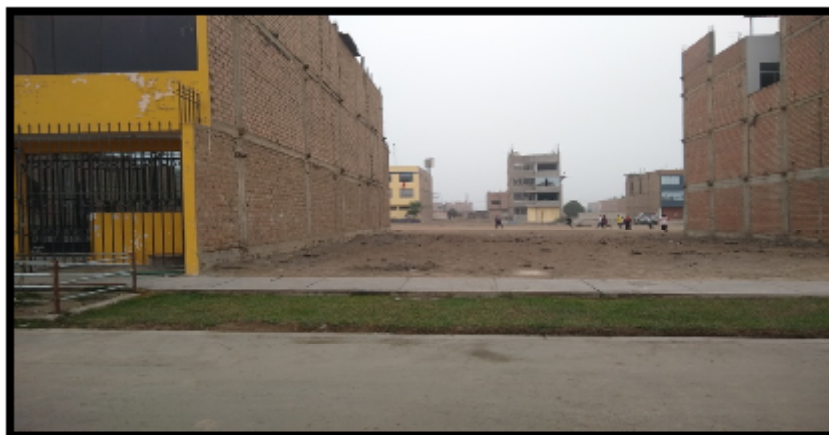
Figura 21: Estado actual del proyecto
