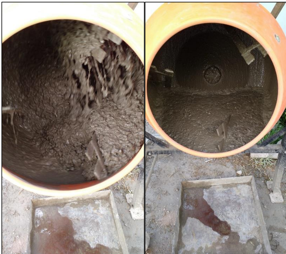
Figura 22: Mezclado concreto con Nano-sílice
