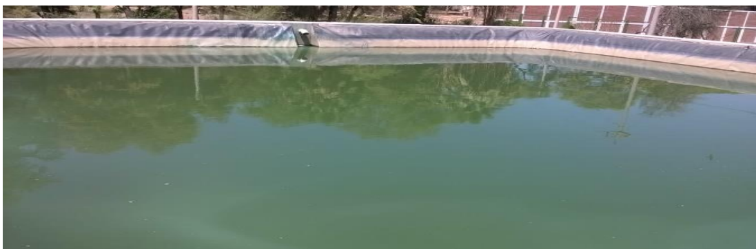
RESERVORIO DE AGUA CRUDA
