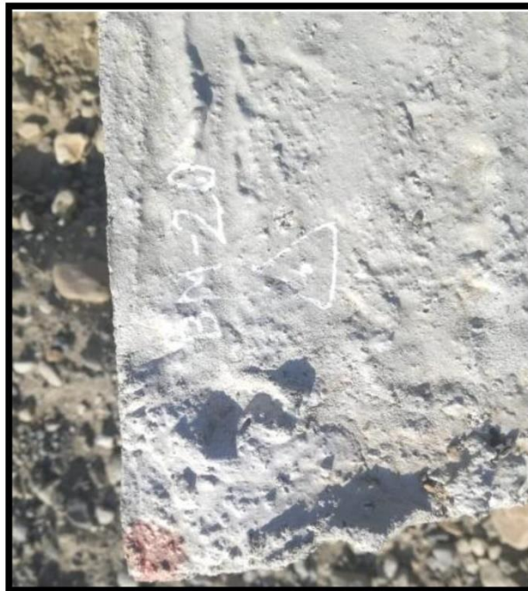
Foto: 12- SE OBSERVA LA MONUMENTACION DEL BM-20 COORDENADAS UTM: 8951420.49 N 799855.61 E 76.62 ELEV.
