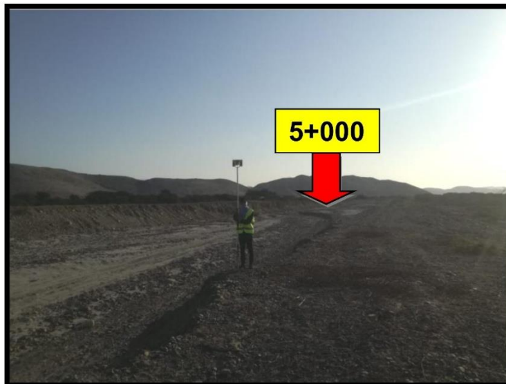
Foto: 13- SE OBSERVA LA PARTE FINAL DEL LEVANTAMIENTO EN LA PROGRESIVA 5+000 DEL AREA A ESTUDIAR.
