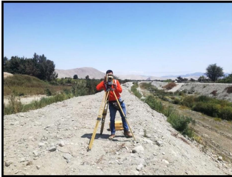
Foto: 05- SE OBSERVA AL TOPOGRAFO EN LA TOMA DE PUNTOS CON LA ESTACION TOTAL ES-105
