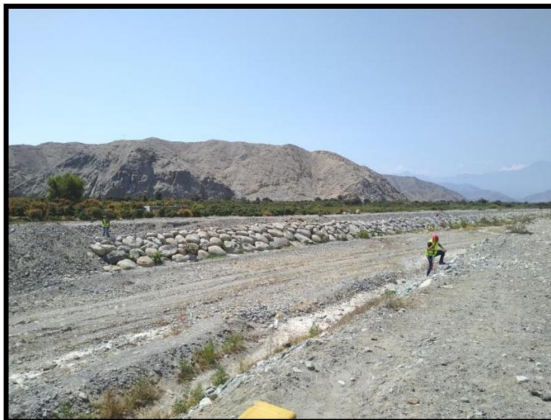
FOTO: 06- SE OBSERVA AL EQUIPO DE TOPOGRAFÍA REALIZANDO EL LEVANTAMIENTO, ASÍ MISMO LA PRESENCIA DE ENROCADO EN LOS BORDES DEL RIO
