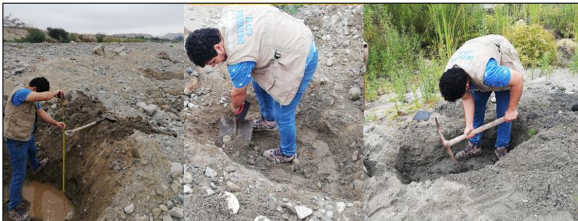
Figura N°04: Realizando la excavación manual para la extracción de muestra y a posterior ser analizada en el laboratorio.
