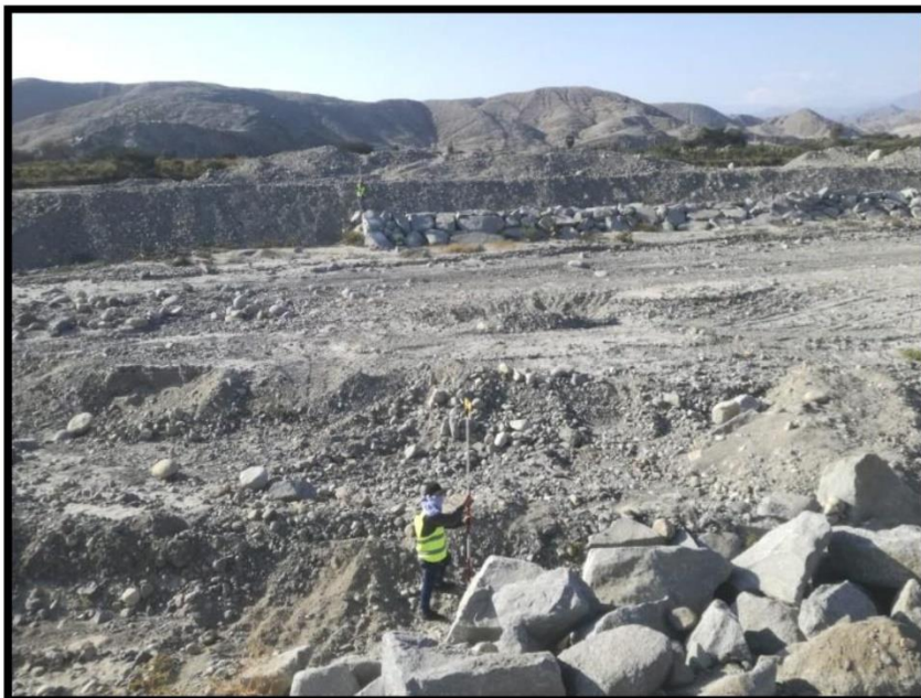
Foto: 08- SE OBSERVA EL FINAL DEL ENROCADO DE ESE TRAMO.
