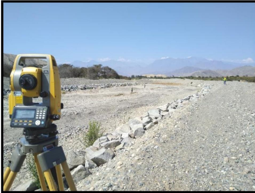
Foto: 07- SE OBSERVA A LOS ASISTENTES EN LA TOMA DE PUNTOS, Y AL RIO SECHIN SECO, ENROCADO A LOS BORDES.
