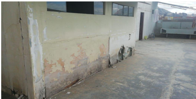
Fotografía N° 6 Muros de dormitorios de efectivos policiales.
