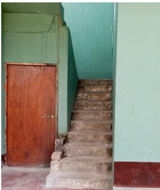
Fotografía N° 5 escaleras del segundo nivel.
