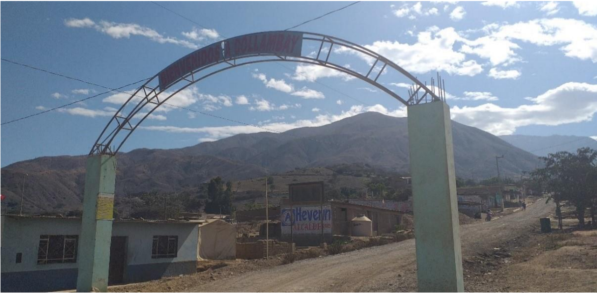
Fotografía 1: Se observa la entrada al caserío Collambay donde se encuentra ubicado nuestro tramo de estudio. Fuente: Elaboración propia
