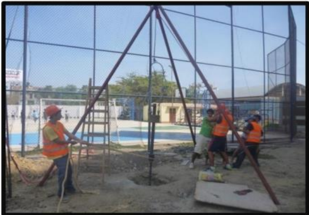
Figura 14. Vista del ensayo de Penetración estándar (SPT), realizado por SL DE INGENIERIA EIRL en el Campus de la UPAO
