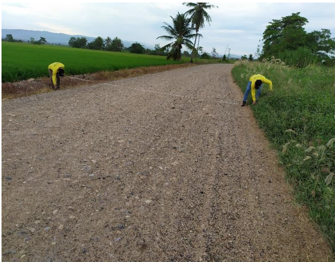
Figura 28: Trazo del ancho de la vida marcado de puntos y calicata
