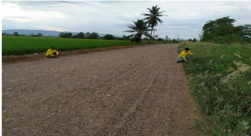
Figura 26: Trazo del ancho de la Vía
