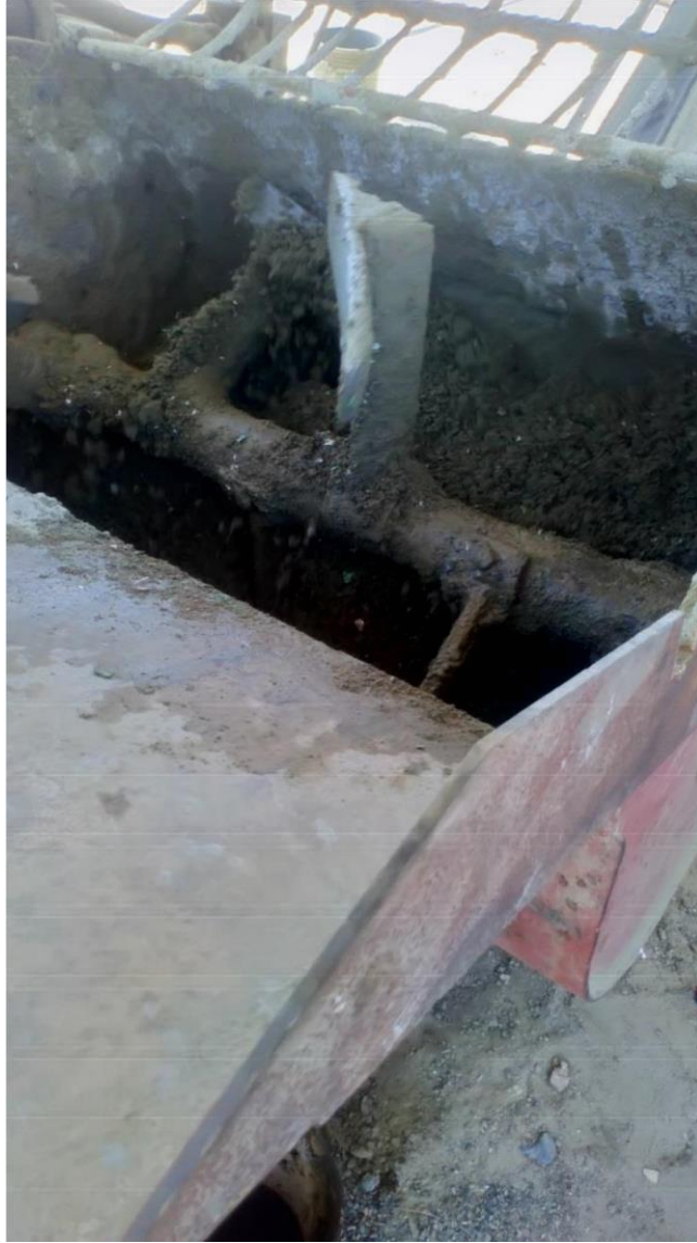
Figura 10. Una vez colocada la proporción de agua, se mezcla todo el concreto
