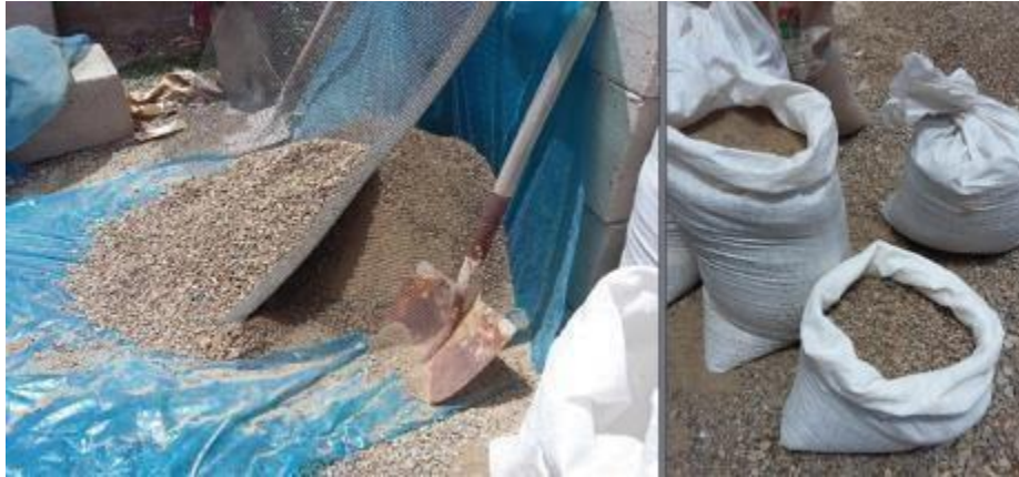
Figura 01. Preparación de agregados
