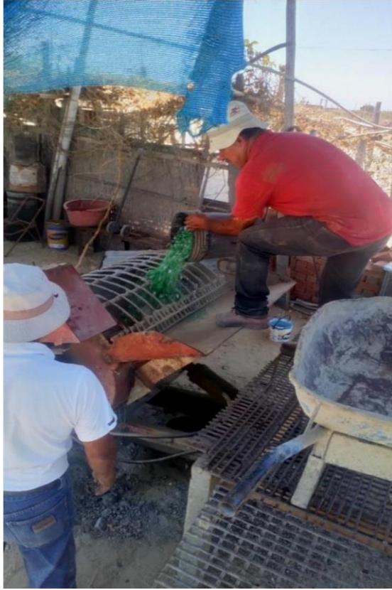
Figura 08. Una vez colocados el agregado fino y grueso, se coloca el Pet.
