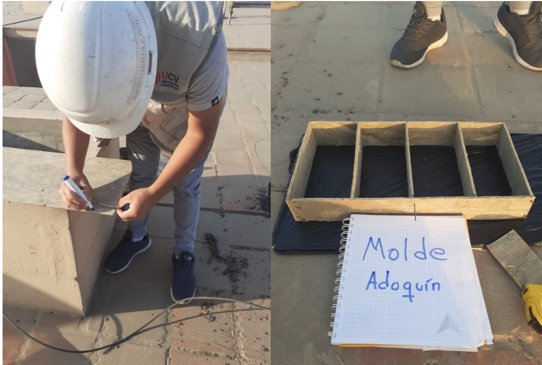
Figura 13: Elaboración del molde del adoquín.
