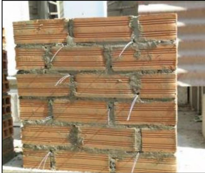
*Figura 17. Amarrado de las mallas electrosoldadas*
