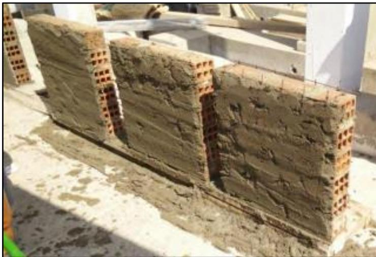
*Figura 18. Tarrajeo en muretes con mallas electrosoldadas*
