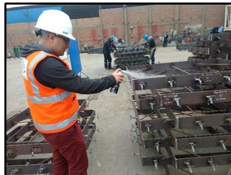
Figura N° 20: Limpieza Mecánica de Pre-Marco Fuente: Elaboración Propia
