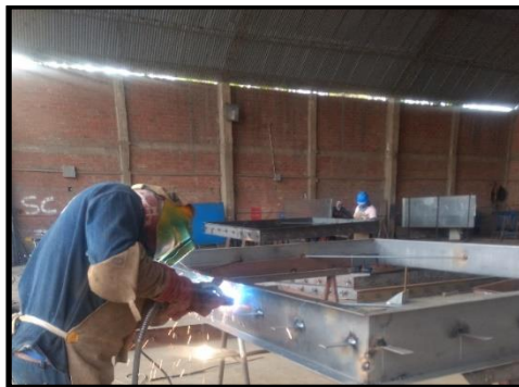
Figura N° 19: Soldadura 2 de Pre-Marco Fuente: Elaboración Propia
