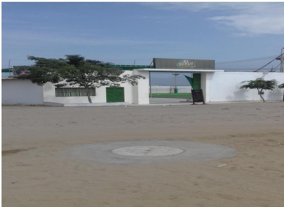
Barrio 7-B Centro Poblado Alto Trujillo (Empalme del Sistema de Alcantarillado)
