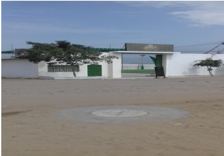
Barrio 7-B Centro Poblado Alto Trujillo (Conexión del Sistema de Agua Potable)
