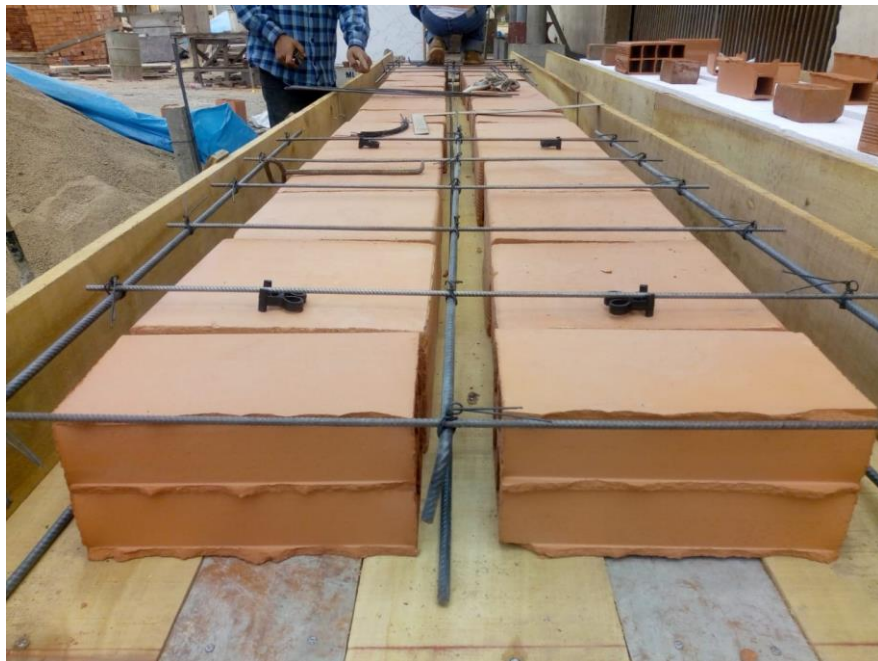
Vista de losa aligerada con ladrillo convencional
