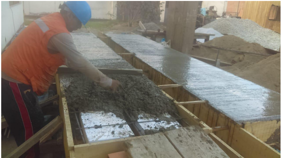
Vaceado en losa aligerada con ladrillo compuesto
