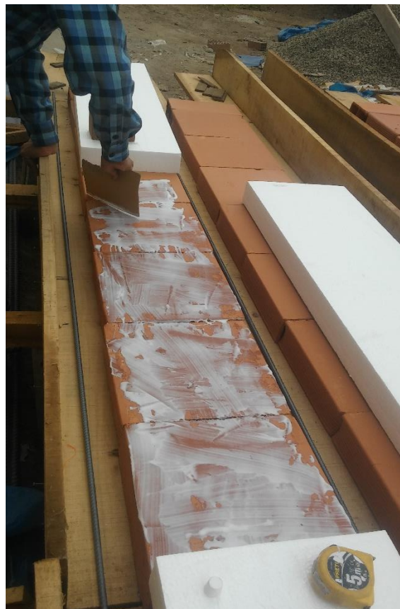
Colocación del pegamento para adherir el poliestireno expandido
