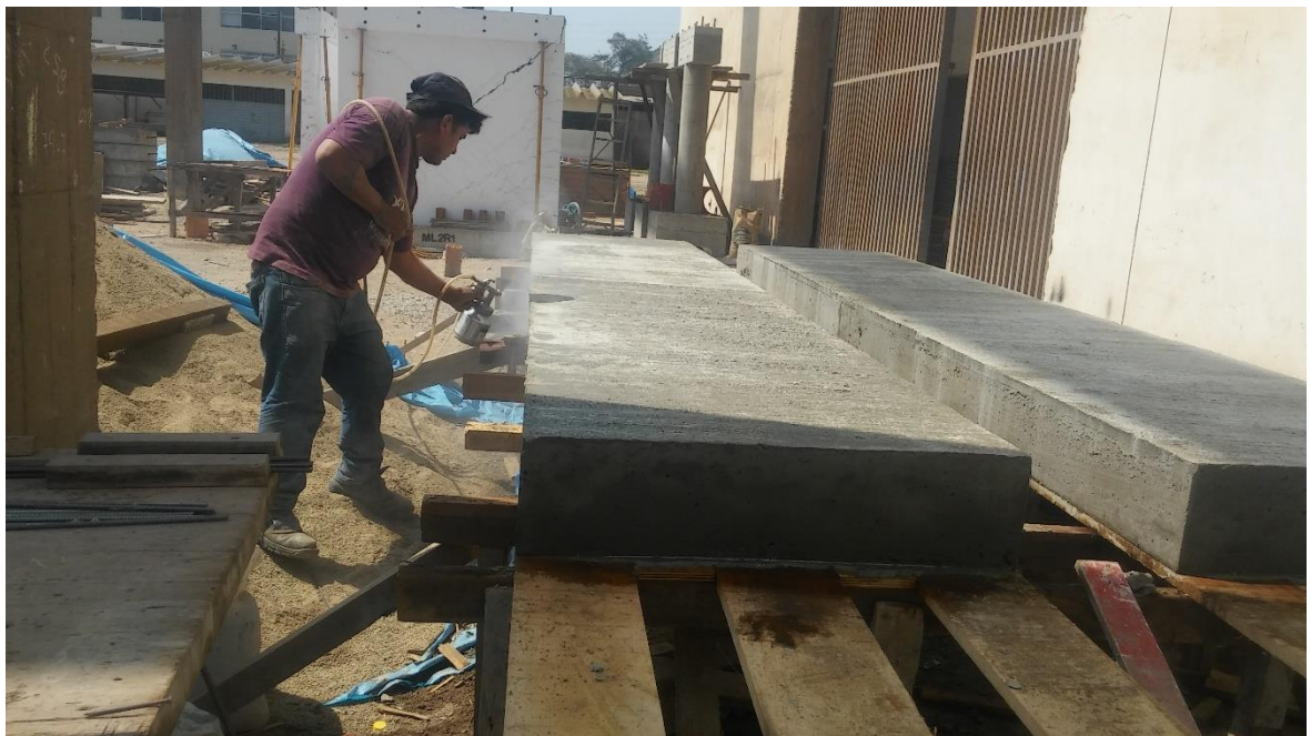
Realización del curado químico para la losa aligerada convencional y compuesto
