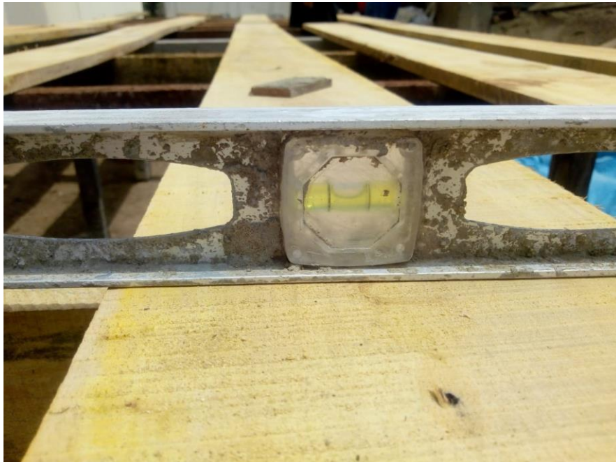
Verificación del nivelamiento del encofrado
