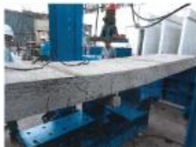
Figura 23. Vista de las grietas laterales en la losa (P-02)
