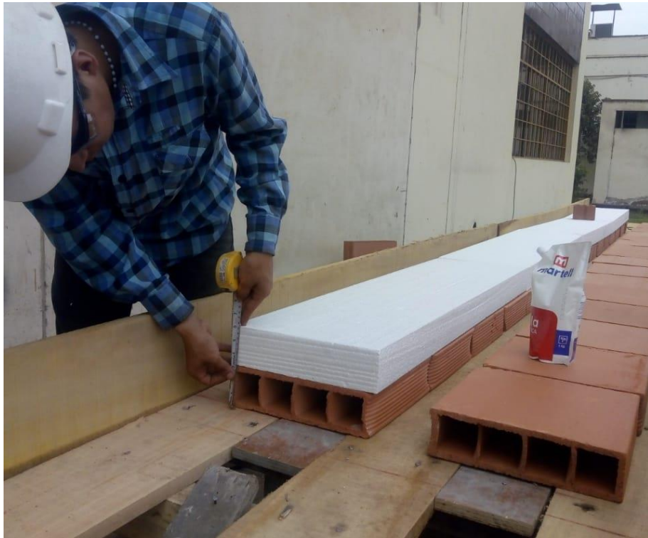
Verificacion del espesor del ladrillo compuesto e=15\text{cm}
