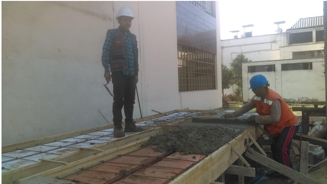
Vaceado de concreto en losa aligerada con ladrillo convencional
