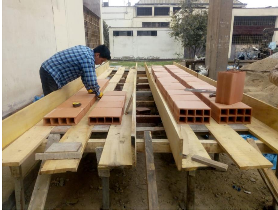
Habilitación de ladrillo de 30x30x8 cm que conformara el ladrillo compuesto
