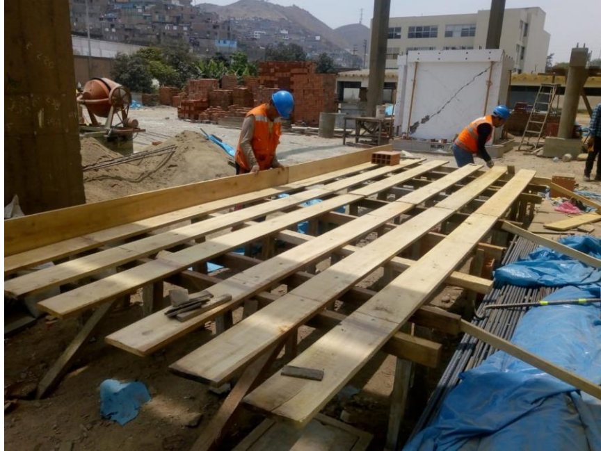
Encofrado de losa aligeradas
