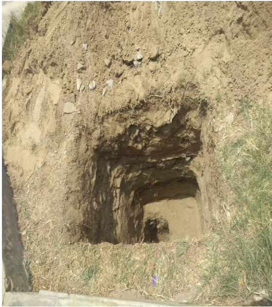
Figura 13: Excavación de calicata
