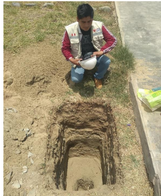
Figura 14: Sondaje de calicata
