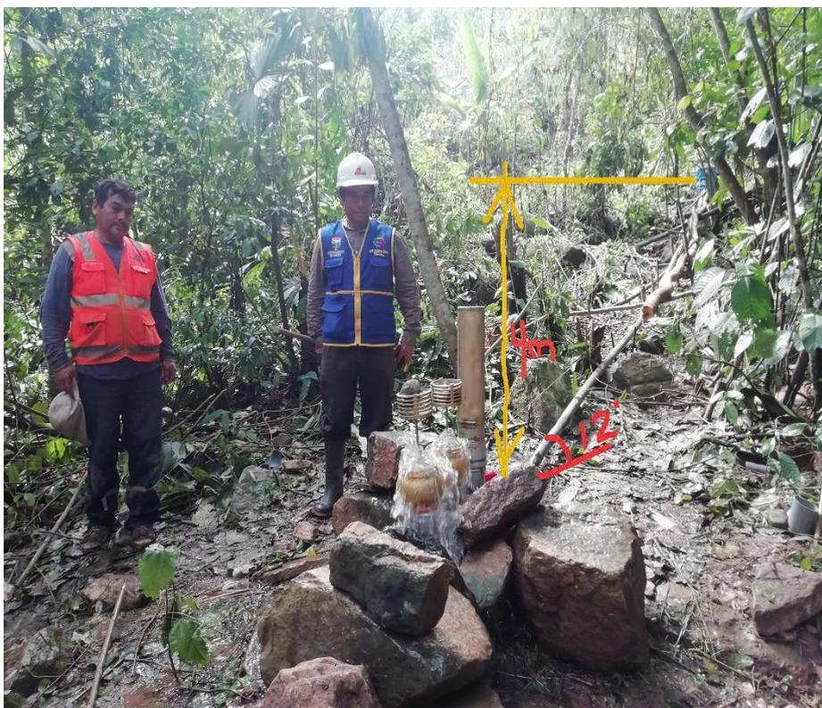
Fig. 15 Sistema 12° de inclinación con una pendiente de 20 % y un desnivel de 4 m entre la altura de trabajo y el nivel de referencia.
