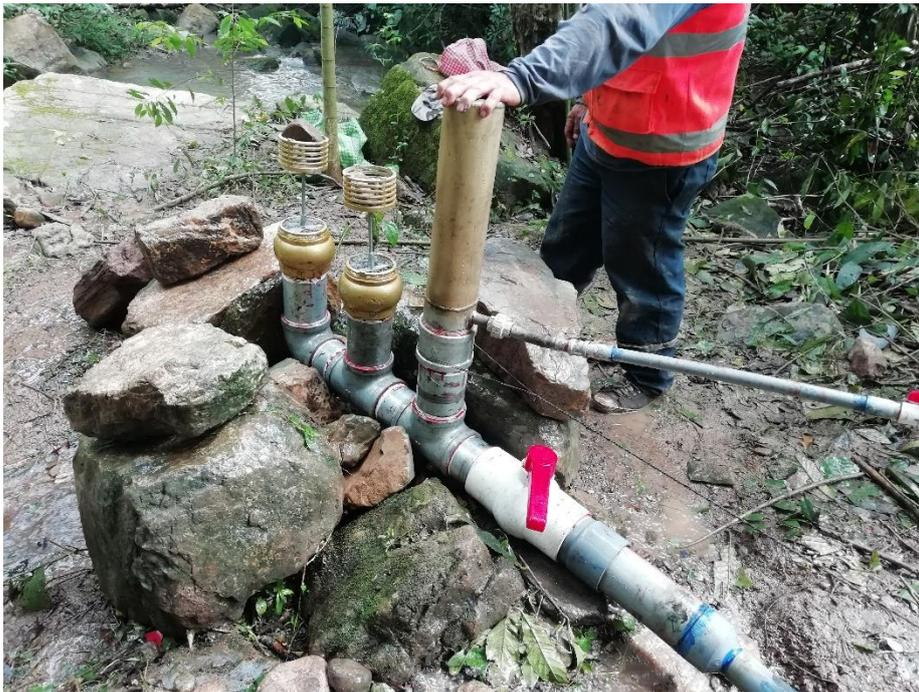
Fig. 14 Bomba hidro-mecánica de 4 pulgadas
