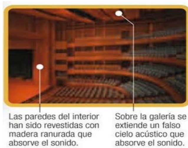
Figura 58. Materiales de la Sala Principal del Gran Teatro Nacional del Perú. Fuente: https://www.proyectosapp.pe/RepositorioAPS//0/2/JER/PC_GTN/PPT_GTN_ESP___ACT_21_08.pdf
