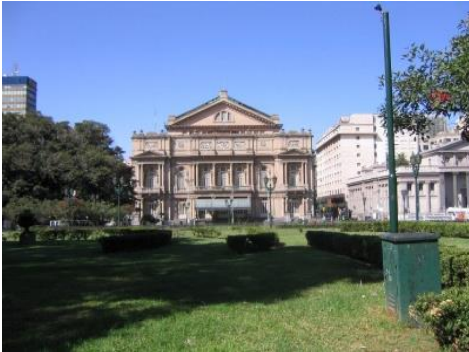
Figura 64. Teatro Colon. Fuente: https://es.wikiarquitectura.com/edificio/teatro-colon/#teatro-colon-00
