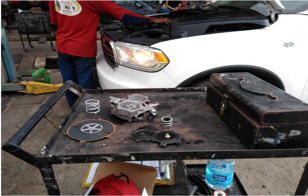
*Figura 12.* Equipo de sistema de gas desarmado en mantenimiento. Para el mantenimiento del gas se desarma el reductor de gas para hacer una limpieza general y cambiar los accesorios que se requiere por el tiempo y el uso ya trabajado en el vehículo. Fuentes: Taller de conversiones a GNV Autogas HyD Automotriz.
