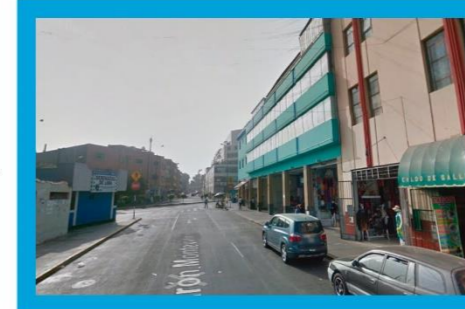
JR. ANDAHUAYLAS GALERIA COMERCIAL
