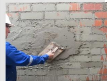
Muro de ladrillo
