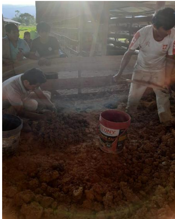
Foto N° 06: Vista de amasado y elaboración de las muestras adicionado con ceniza de cascarilla de arroz en la Ladrillera Alto Mayo – Rioja.
