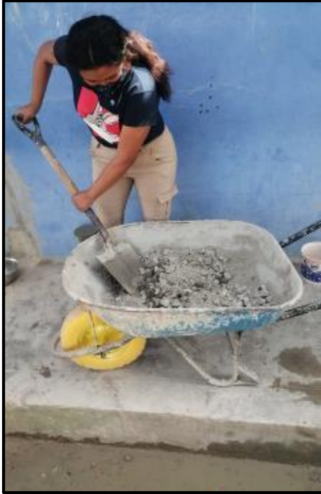
Figura N° 19 y 20: Proceso de mezclado de los materiales para elaboración de concreto.
