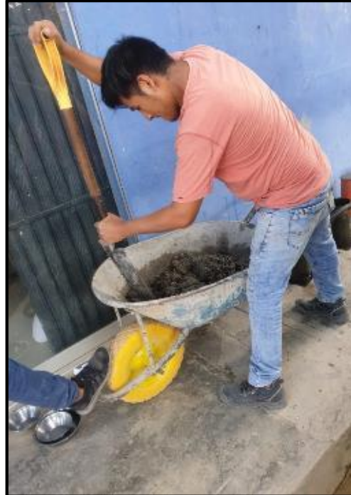
Figura N° 19 y 20: Proceso de mezclado de los materiales para elaboración de concreto.
